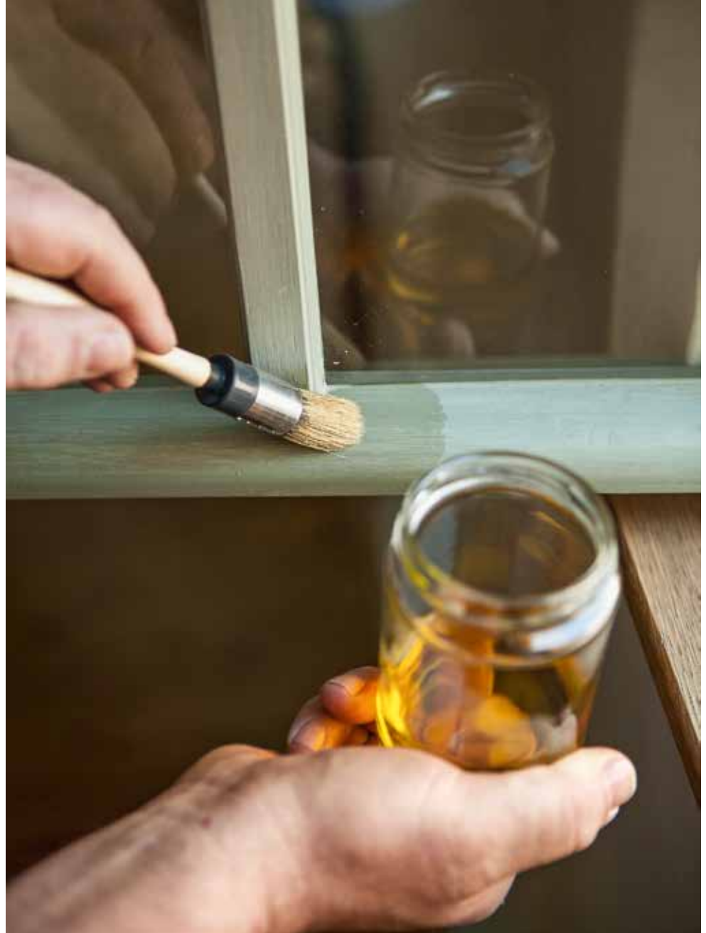
Wirkt die Farbe mit der Zeit stumpf, wird sie mit rohem kaltgepressten Leinöl wieder aufgefrischt. Das macht den Anstrich fast unbegrenzt haltbar.
