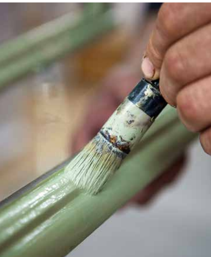
Das weiße Fenster erhält den ersten, das grüne Fenster den letzten von drei Farbanstrichen. Wichtig: die Farbe dünn auftragen.
